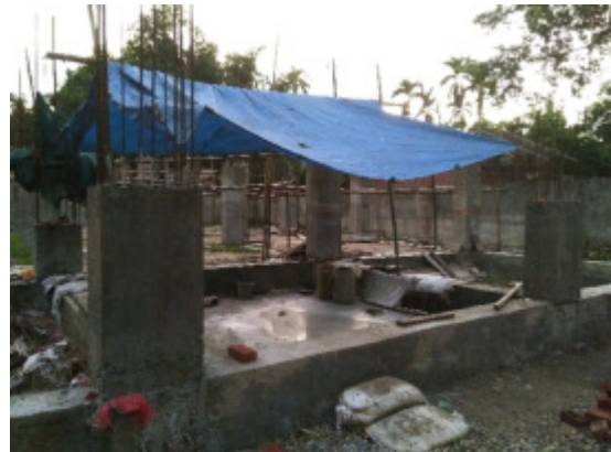
Hier entsteht eine Teefabrik, die auf Bio-Tee ausgerichtet ist. Die Fabrik soll im April 2020 öffnen und wird mit ELCITHS zusammen arbeiten.
